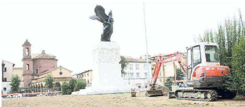
I lavori in piazza della Vittoria
